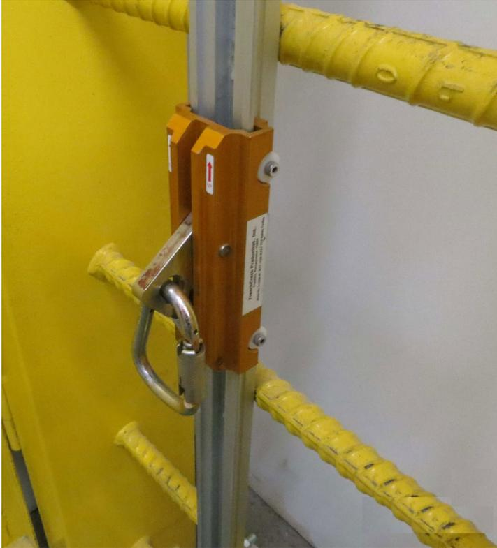
**Fotografía 4.** Sistema de seguridad de la escalera de mano, que consta de un carrito deslizante con un punto de amarre, sujeto a un riel montado en la escalera de mano.
