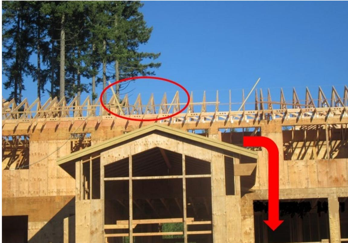
**Fotografía 2.** Se había instalado una cuerda salvavidas en una armadura (en el círculo) y estaba disponible justo debajo del borde superior del techo, frente a una ventana, donde el instalador de estructuras pudo haberla usado antes de subir al techo. La flecha muestra el lugar donde cayó el instalador de estructuras.
