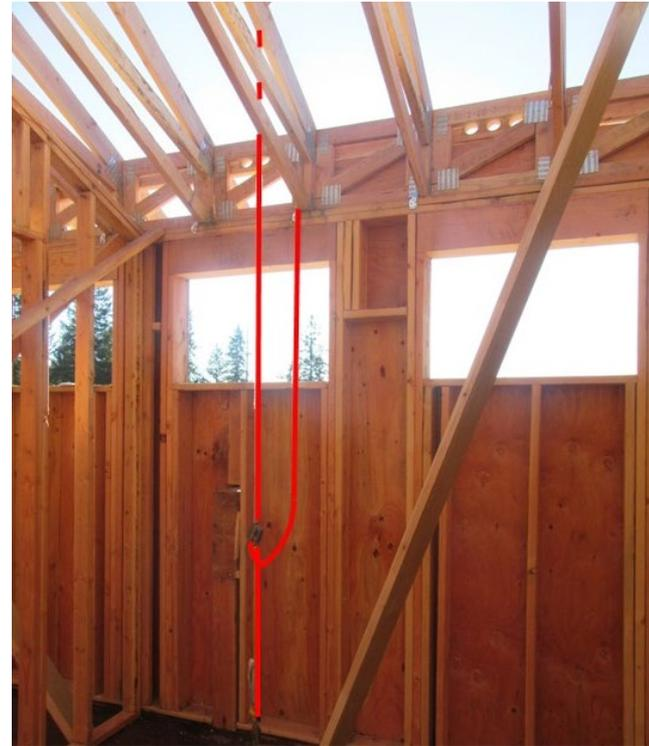
**Fotografía 5.** Cuerda salvavidas que pudo haberse usado. El techo al que subió el instalador de estructuras se encuentra en el otro lado de la pared.
