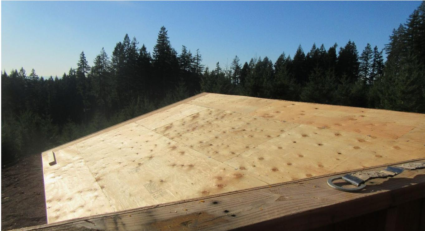
**Fotografía 3.** Vista desde el techo revestido inferior trasero. El instalador de estructuras cayó desde aproximadamente la mitad del borde del lado izquierdo. Un punto de anclaje en la ventana aún está visible en la parte inferior derecha.
