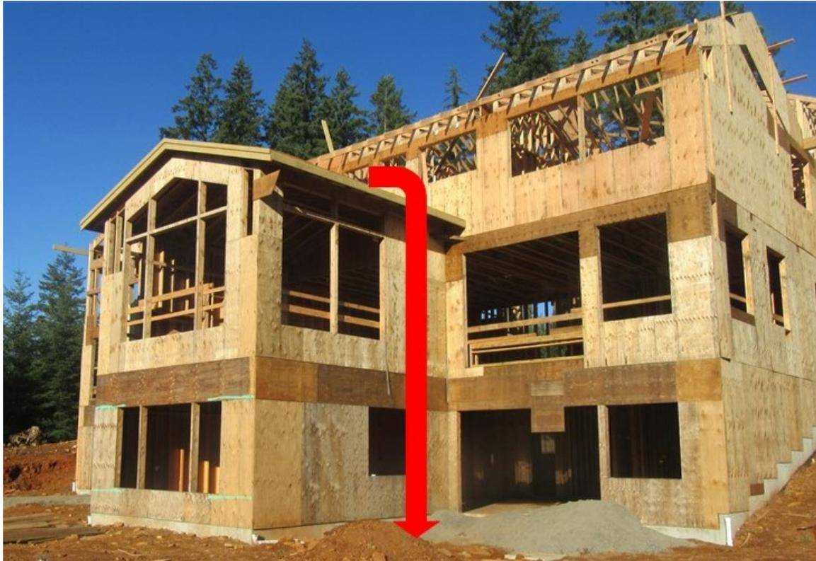
**Fotografía 1.** Casa donde un instalador de estructuras cayó 25 pies desde el techo revestido inferior trasero. No estaba usando protección contra caídas.
