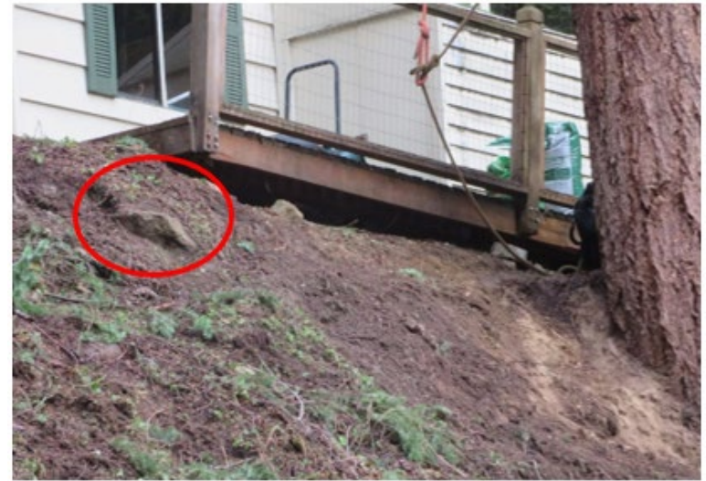
Fotografía 4. Acercamiento de la roca en la que el trabajador se golpeó la cabeza.
