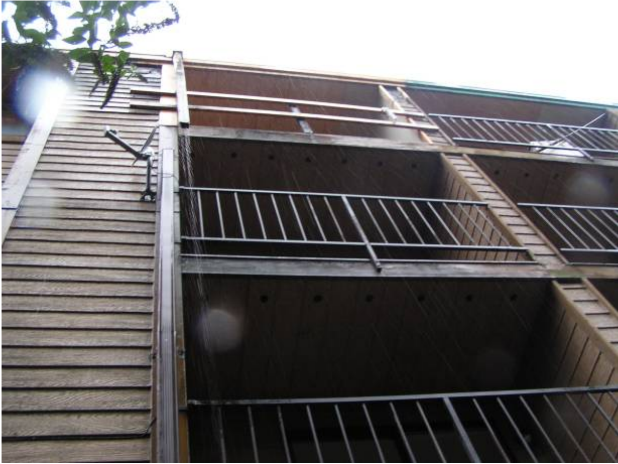
Ilustración El balcón del apartamento con un barandal temporal reconstruido después del incidente.
