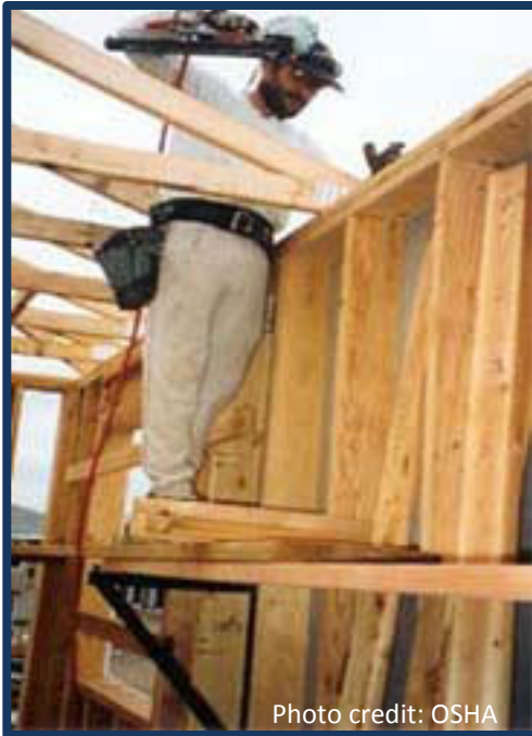
Fotografía 3: Andamio con soporte de pared
