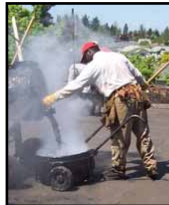
Transfiere asfalto de una caldera a una carretilla de trapeador
