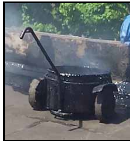
Transferir asfalto caliente en carros de trapeador es más seguro que utilizar baldes de mano.
