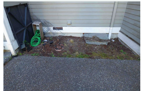
Figura 2: El capataz cayó sobre el concreto después de caer desde 15 pies desde el techo húmedo.
