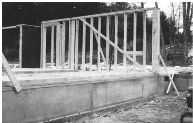
**Colocación de la estructura de las paredes exteriores**
