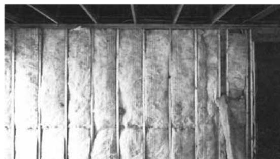
Instalación de aislante en las paredes
