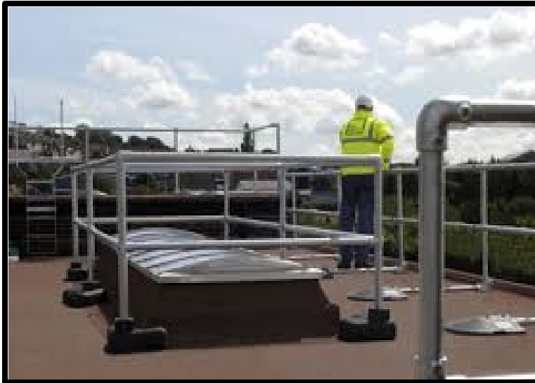
Tragaluces protegidos con barandas.
