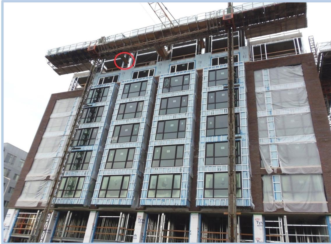
Escena del accidente que muestra el exterior del edificio y el andamio bimástil. El círculo rojo en la foto muestra el área donde el herrero cayó por una apertura de 55 pulgadas entre el andamio y el edificio.
