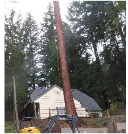
Abeto que el equipo de trabajo estaba retirando en secciones.
