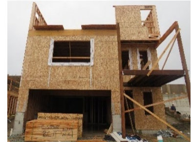
Piso superior sin paredes del que se retiraron los barandales.
