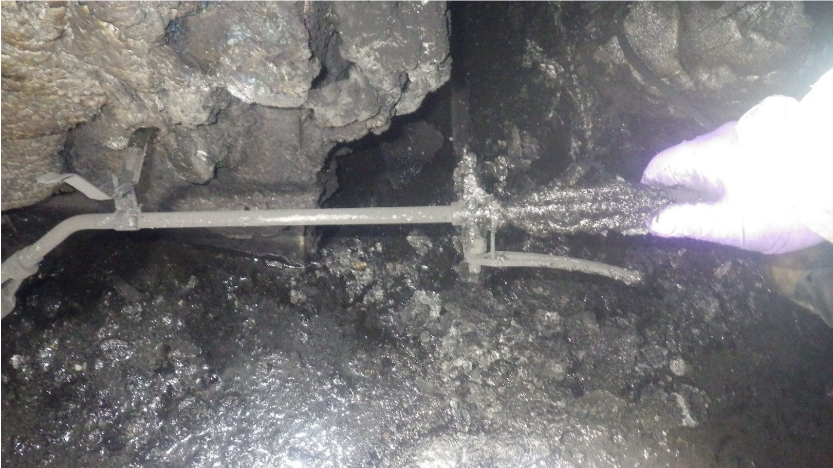
Fotografía 4. Soplete de propano manual utilizado para calentar el adhesivo.
